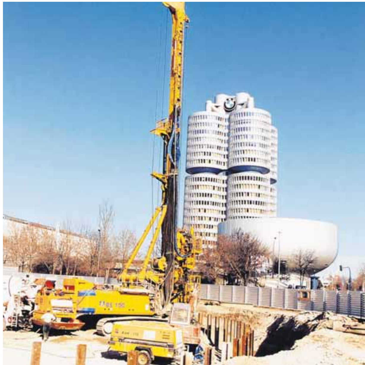
Der gesunde Mix aus mittelständischen Betrieben und Weltmarktführern, im Bild eine Baustelle der Bauer AG in München, machen den Landkreis Neuburg-Schrobenhausen deutschlandweit zu einem wirtschaftlichen Schwergewicht. Archivfoto: privat
